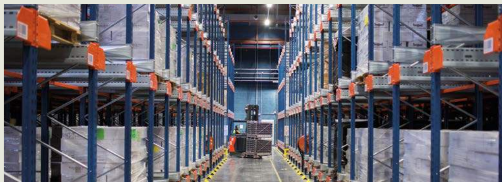
Figure 13. Rayonnages métalliques avec protections de pieds © Rodolphe Escher pour l'INRS
