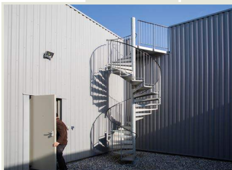
Figure 2. Accès en toiture © Albert Pereira pour l'INRS
